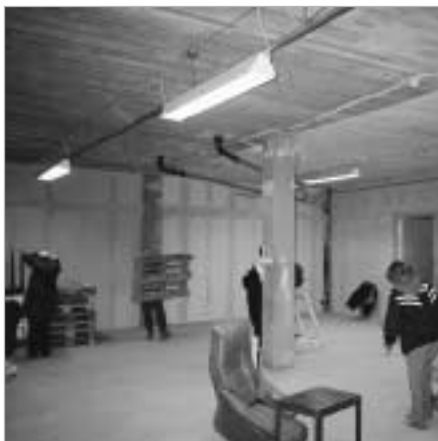
Ny dojo under uppbyggnad
